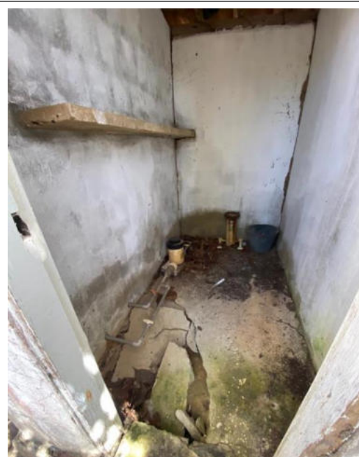
Figura 4 – Abrigo do clorador e clorador sem uso, atualmente. Instalado na rede adutora ligada ao reservatório que se encontra desativado (vista interna).
