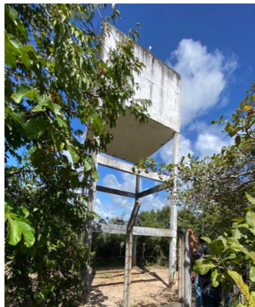
Figura 2 – Reservatório elevado de concreto, com capacidade para 100mil litros. Desativado.
