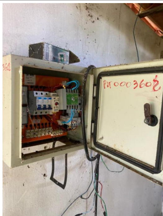
Figura 5 – Quadro de comando elétrico da bomba, poço 2.
