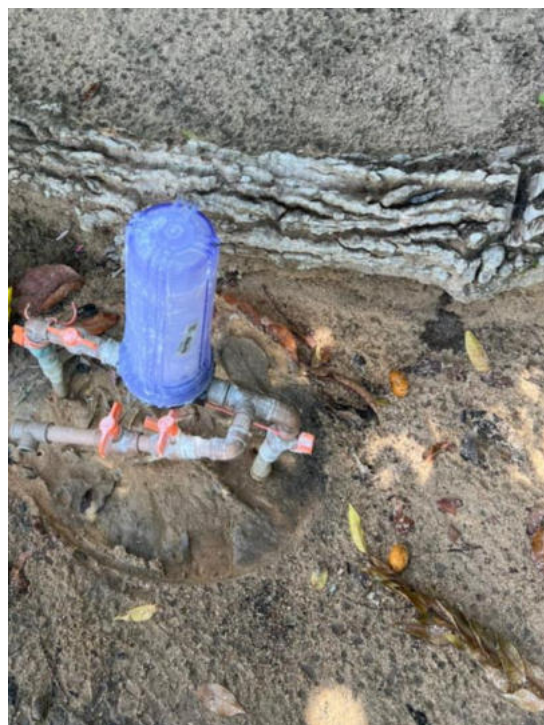
Figura 13 – Dosador de cloro em pastilhas (clorador). Instalado diretamente na rede de distribuição.
