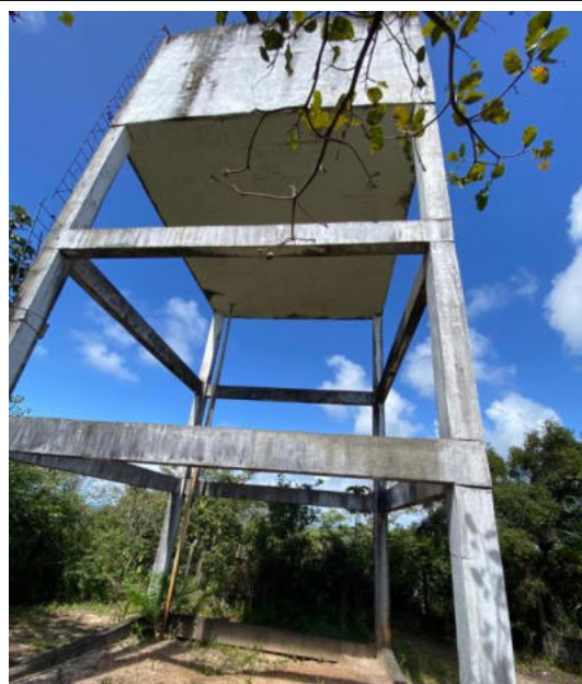
Figura 1 – Reservatório elevado de concreto, com capacidade para 100mil litros. Desativado.
